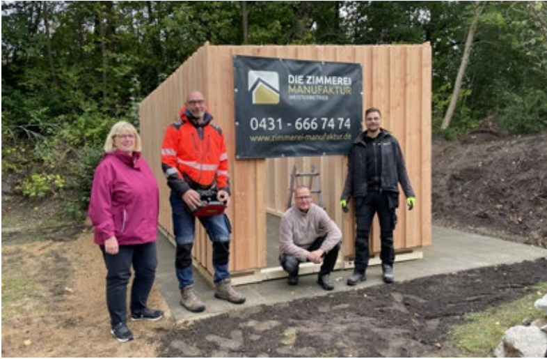
Zufriedene Gesichter nach fachmännisch ausgeführter Gemeinschaftsarbeit: Katarina Burmester, Peer Schnoor vom Bau-Dienst-Kiel, Dachdecker Frank Burghard sowie Zimmermann Bernd Mehlretter freuen sich, dass der Schuppen seinen Platz auf dem vorbereiteten Fundament eingenommen hat.
